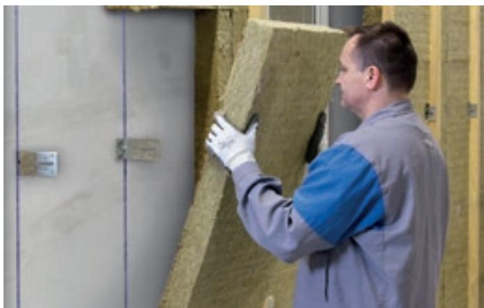
La ventilation de la face arrière des panneaux doit être assurée par une lame d'air d'épaisseur 2 cm minimum. Il est important d'assurer l'entrée, la sortie et la circulation de l'air sur toute la surface du bardage.
