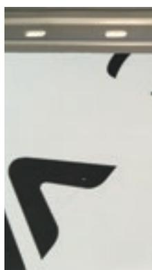
La dilatation est gérée par des trous oblongs tout au long de l'élément (perçement 5 x 15 mm) à l'endroit des fixations.
