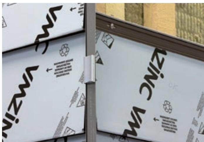
Enclencher les angles directement dans les clips. On procède à l'identique pour les angles rentrants.
