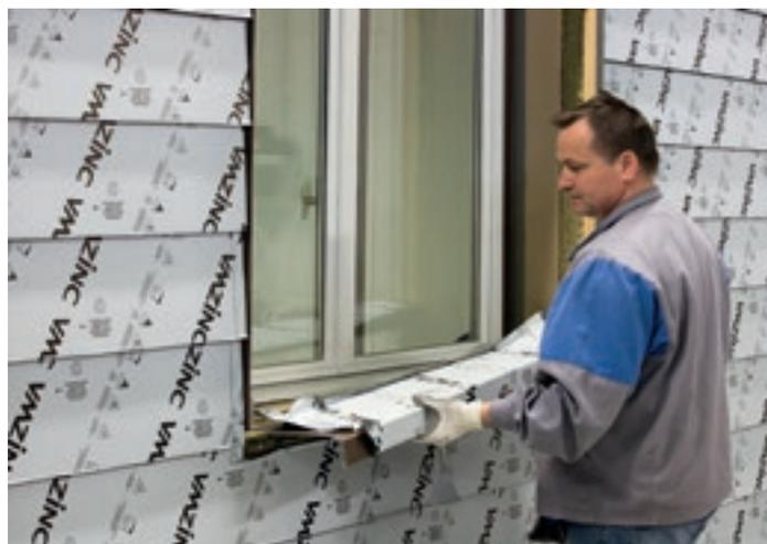
**Tableau** Ajuster les tableaux au châssis de la fenêtre et les glisser dans la pince de réglage.
