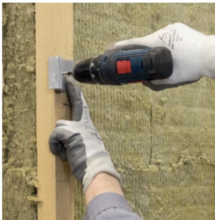
L'utilisation du gabarit est l'assurance d'un bon positionnement des clips et d'une pose simplifiée des finitions.
