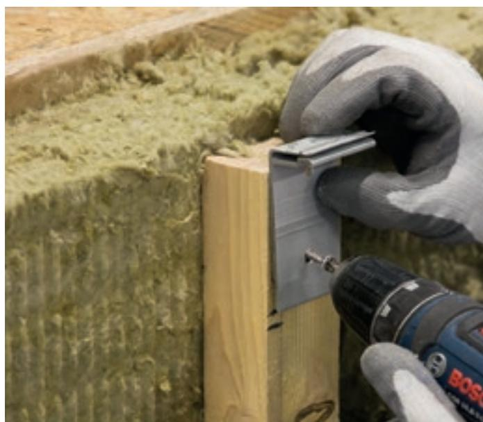
La fixation du dernier clin sous l'appui de fenêtre doit être réalisée par vissage au travers du clip avec des vis auto-perceuses (diamètre 4,8 tête 12 mm).
