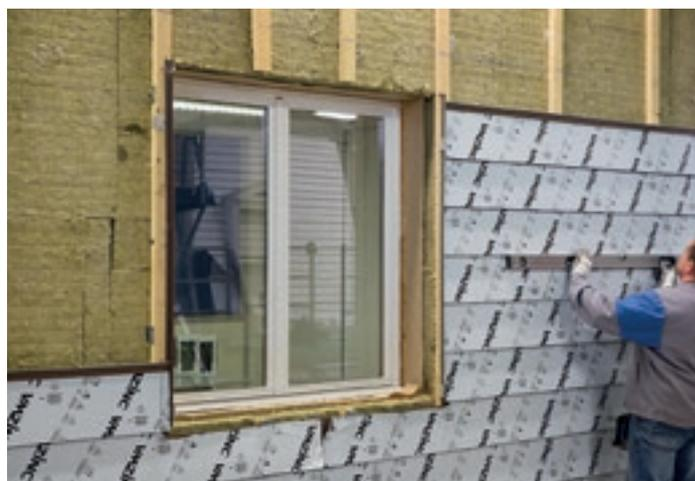
À l'aide d'un niveau, on vérifiera régulièrement, au fil de la pose, que les profils sont toujours parfaitement horizontaux.
